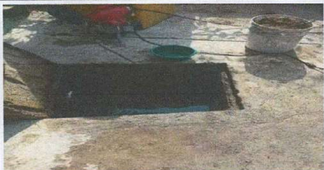
Módulo 4: Sustitución e instalación de biodigestor de 1300 lts.
