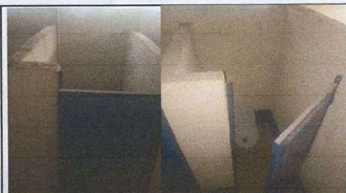
Módulo 2. : mejoramiento y reinstalacion del sistema hidraulico de los sanitarios por medio de la instalacion de una bomba de agua sumergible para que alimente los tanques de los sanitarios.
