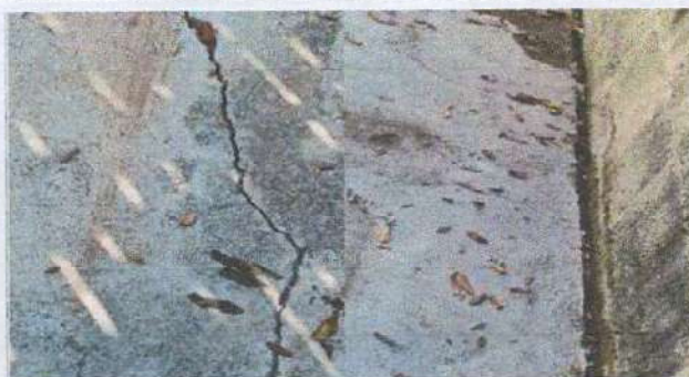
Módulo 4: Sustitución de losa de patio
