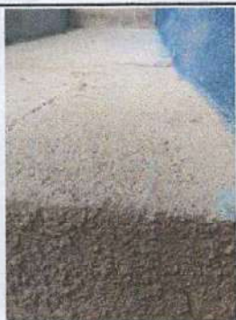
Módulo 4: Sustitución de gradas de concreto por rampa de concreto
