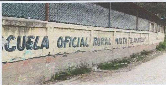
Módulo 5: Aplicación de pintura en muros interior y exterior
