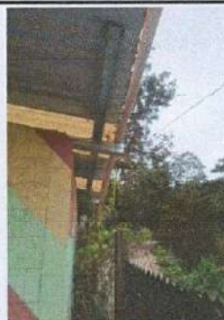
Módulo 2: Sustitucion de canal de aguas pluviales.
