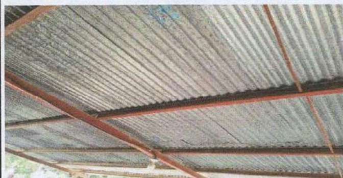
Módulo 1: Sustitución de estructura metálica y lamina del corredor.
